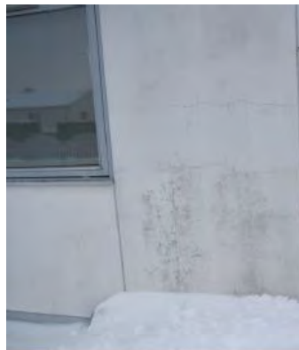
Foto nr. 3 - Billede af fugt på gavl
