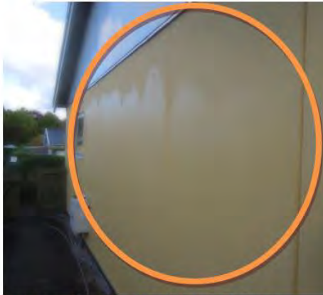
Foto nr. 3 - Billede af fugt på gavl
