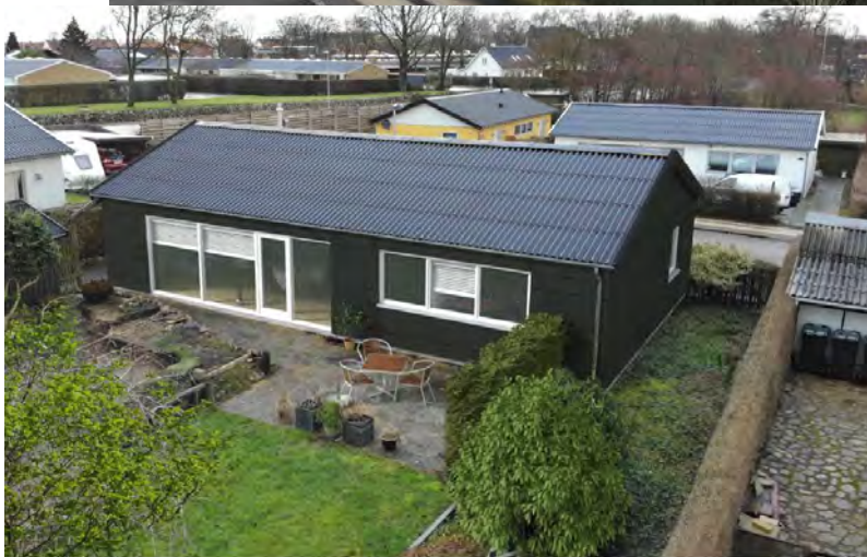
Boliger set fra haven – Vedligeholdelsesfrie facadeplader, hvide træ/alu vinduer og tagudhæng
